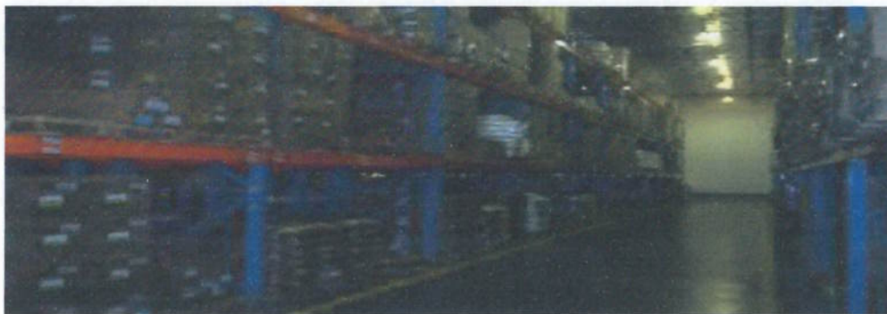
Figura 3.1.3.1 - Estanterias metálicas do centro de distribuição.
